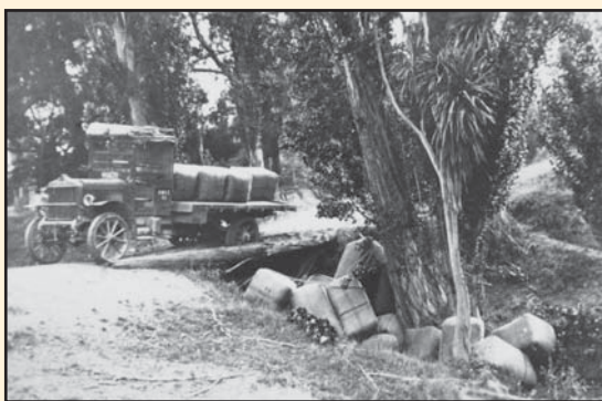
The load spills
